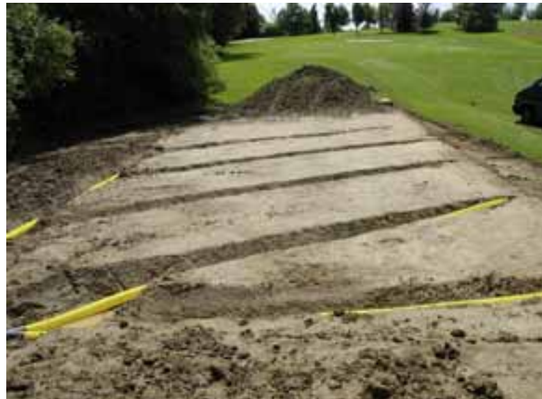
Drainagearbeiten auf der Anlage – natürlich in Eigenregie
